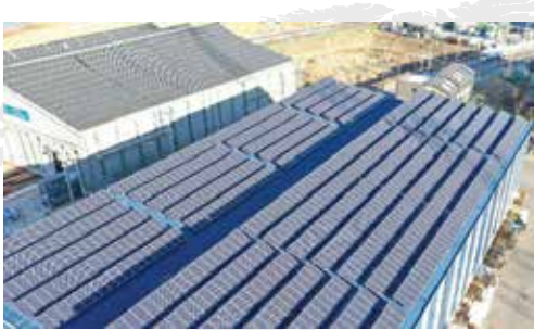
코마스텍 공장동 300KW 급
