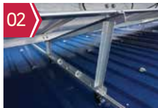
세로바, 가로바 설치
